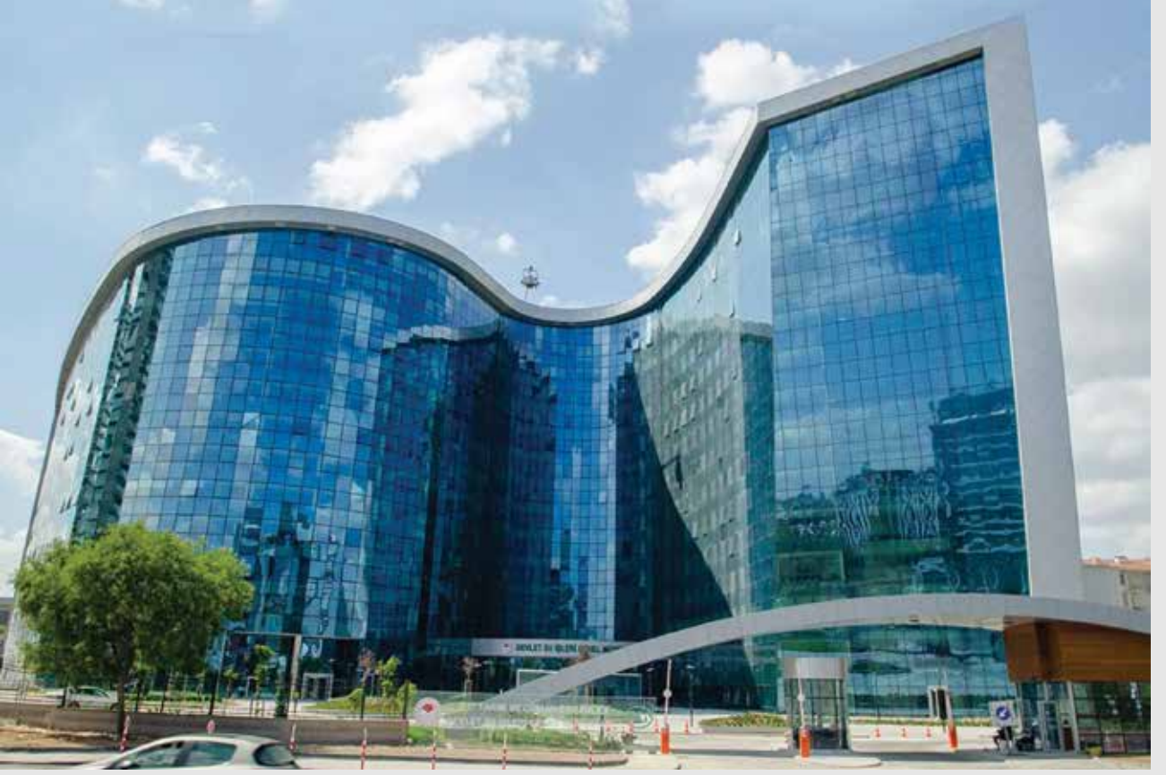
DSİ Genel Müdürlüğü Hizmet Binası, Ankara
